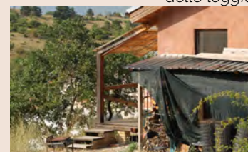
Vista laterale della loggia dell'edificio B
