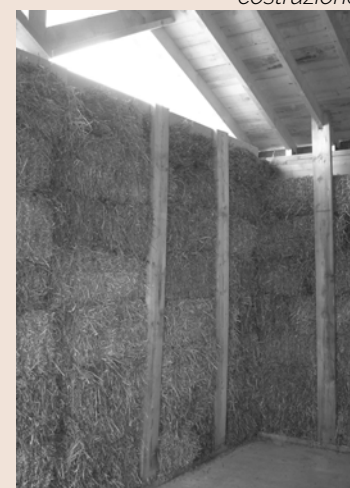
Riempimento in fase di costruzione (interno)
