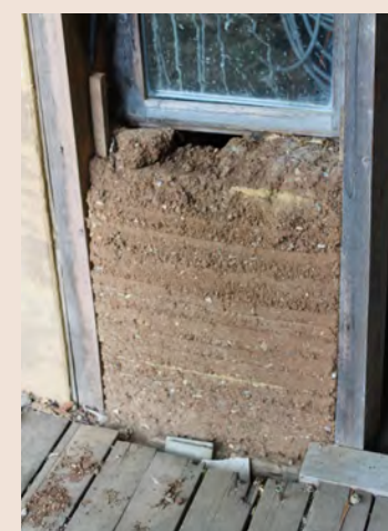
Stato attuale del muro in terra battuta
