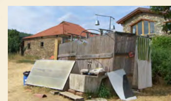
Docce solari oggi
