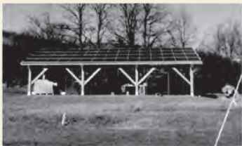
Tettoia fotovoltaica in costruzione
