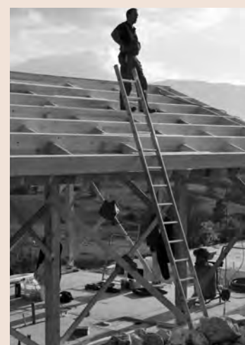
Spazi ricavati per la posa della cellulosa espansa
