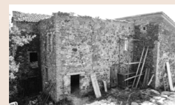
Stato iniziale delle murature
