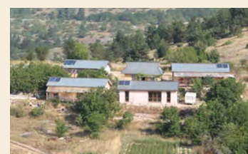
I pannelli in copertura
