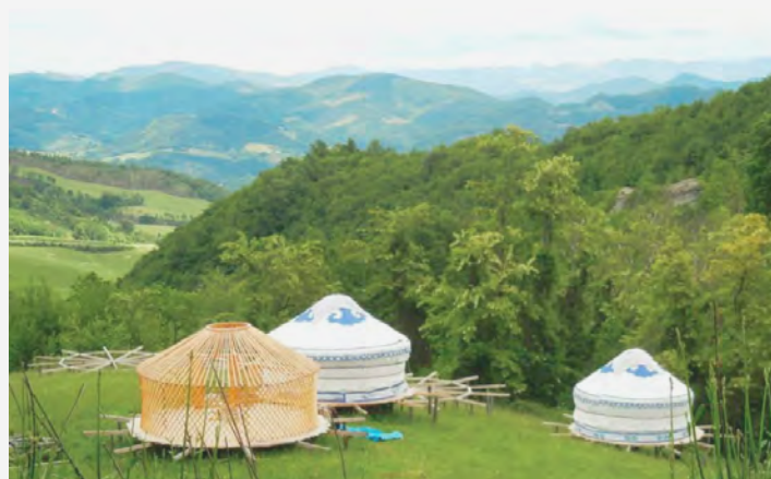
38/ Yurte in costruzione, ecovillaggio Yurt Paradise
