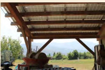
Tettoia fotovoltaica oggi
