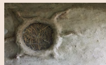
Oblò nell'intonaco da cui si nota il riempimento in balle di paglia
