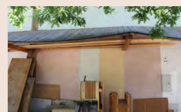
Intonaci differenti, parete esterna tettoia officina
