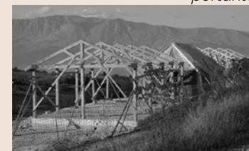
Struttura portante in fase di costruzione
