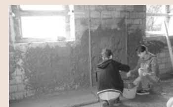
Posa intonaco di corpo su muratura in mattoni
