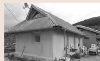
Vista delle finestre triangolari in fase di costruzione
