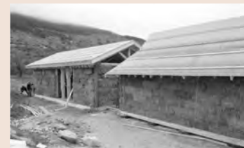
Riempimento con cellulosa espansa
