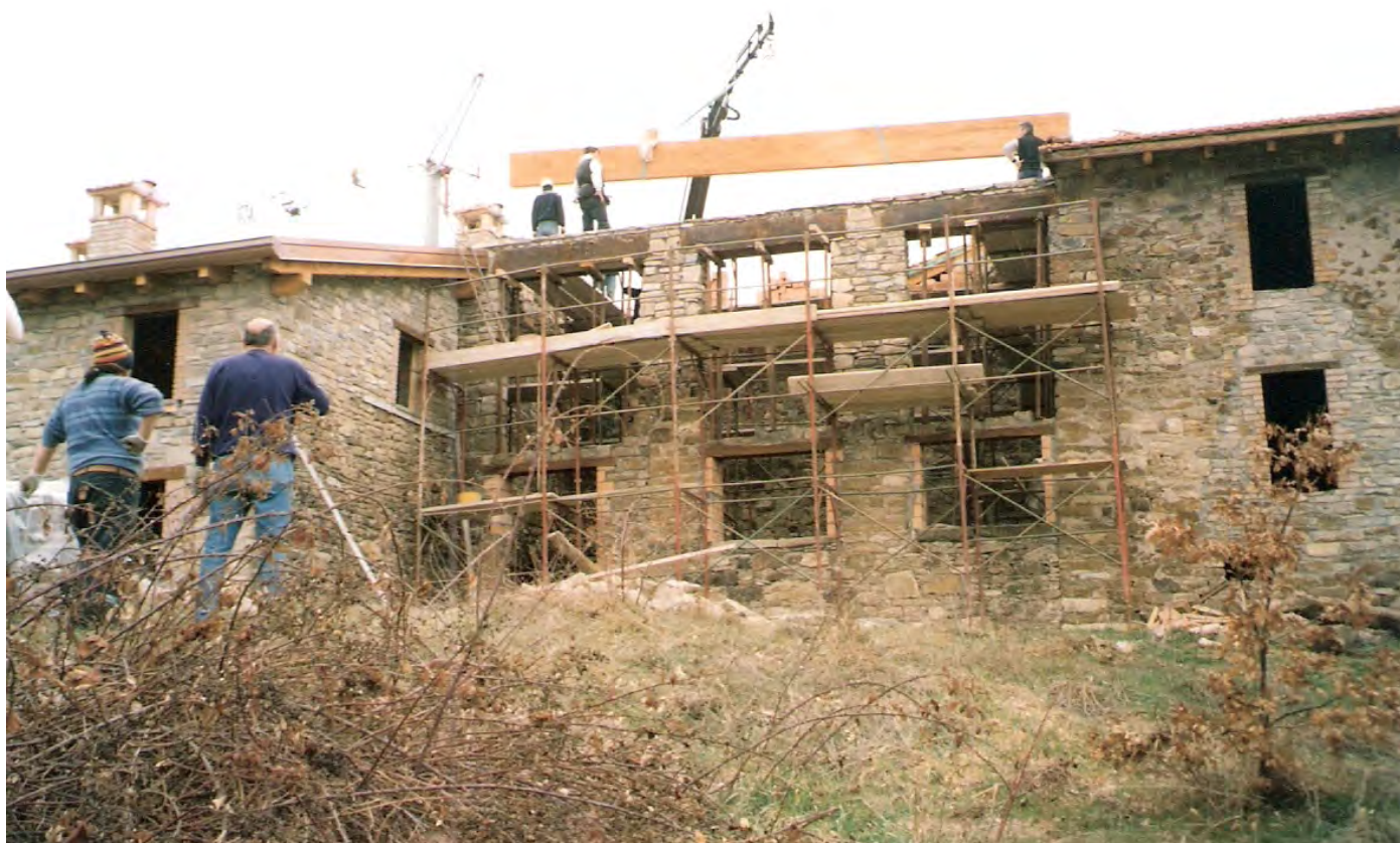
48/Granara durante i lavori di recupero
