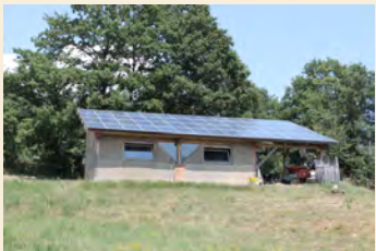
Tettoia fotovoltaica oggi
