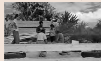
Posizionamento della struttura sui copertoni
