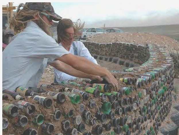
37/ Earthship in costruzione, con bottiglie, terra e copertoni
