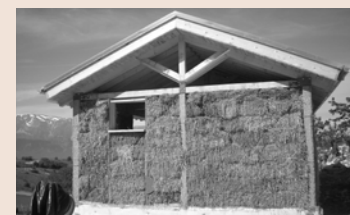
Riempimento in fase di costruzione
