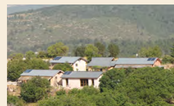
I pannelli in copertura
