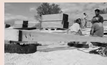
Posizionamento della struttura sui copertoni
