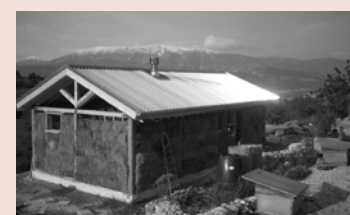
Riempimento in fase di costruzione
