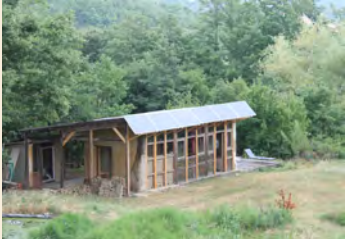
Impianto con accumulo biblioteca
