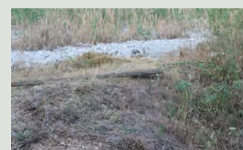
Pendio da consolidare in prossimità della fitodepurazione
