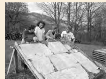
Pannelli solari in costruzione
