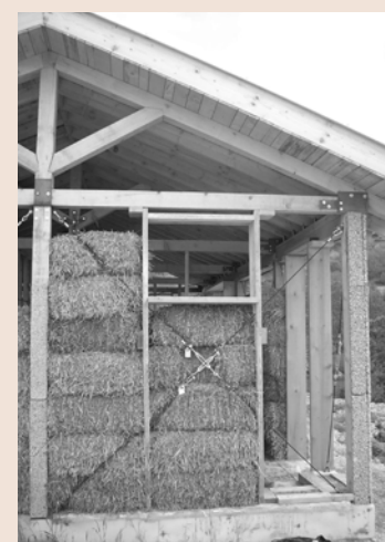
Tiranti in fase di montaggio
