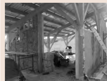
Tettoia officina in costruzione
