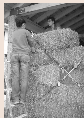
Tiranti in fase di montaggio
