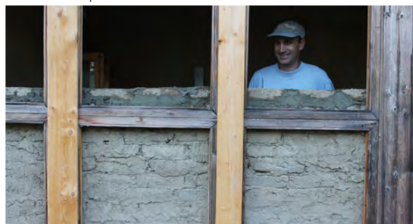
Muro Trombe-Michel in costruzione
