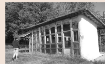
Costruzione parete d'accumulo
