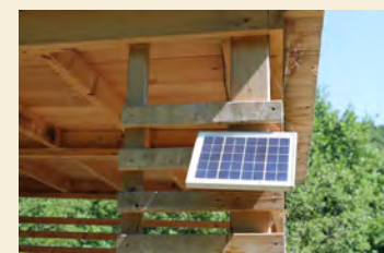
Miniimpianto alle toilet compost
