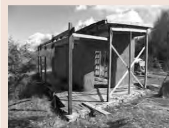
Biblioteca in costruzione
