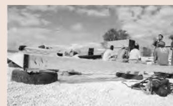
Posizionamento della struttura sui copertoni
