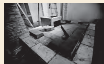
Muratura del camino in costruzione
