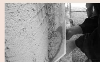
Stesura del rinzafo sull'esterno
