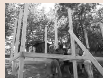
Toilet compost esterne in costruzione
