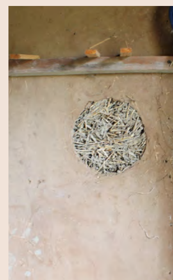
Pannello di controventatura nella casetta, intonacato in terra
