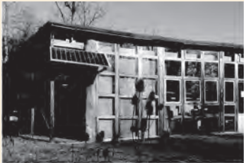
Impianto stand-alone biblioteca
