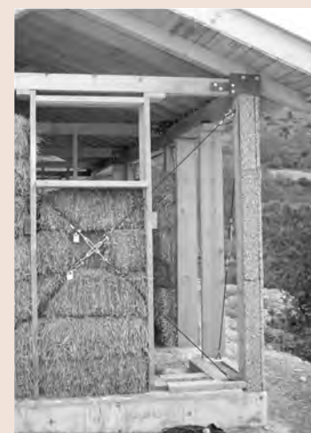
Rivestimento sui pilastri
