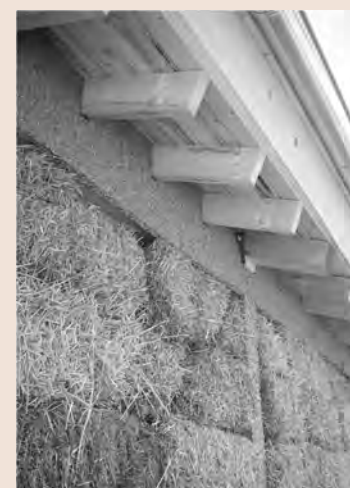
Rivestimento sulle travi
