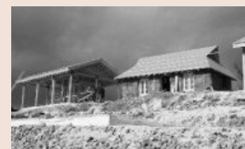
Posizionamento balle e copertura completato
