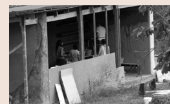
Biblioteca: fase posa intonaco
