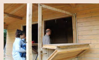
Struttura di cui si ipotizza l'isolamento in sughero
