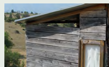
Particolare porzione superiore
