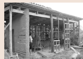
Costruzione struttura lignea
