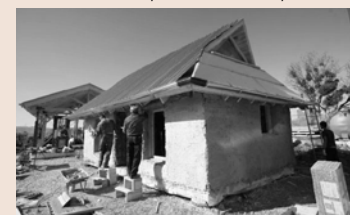
Fase di intonacatura delle balle portanti
