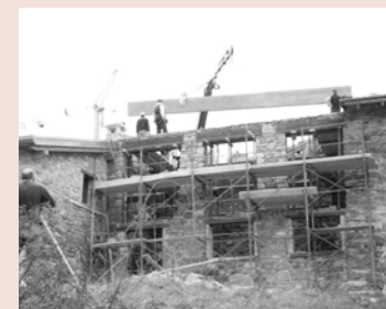
Tetto Granaio in costruzione
