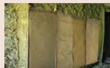
Miscela di intonaco termoisolante per interni, sperimentazione
