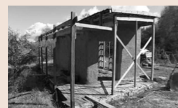
Biblioteca nelle ultime fasi di costruzione
