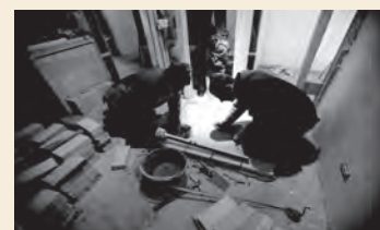
Muratura del camino in costruzione
