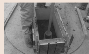
Fase di costipazione della terra
