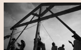
Messa in opera delle strutture
