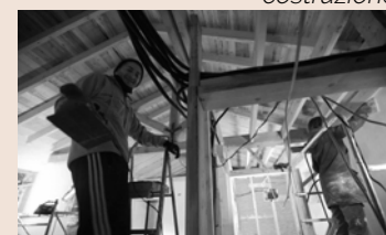
Struttura portante in fase di costruzione
