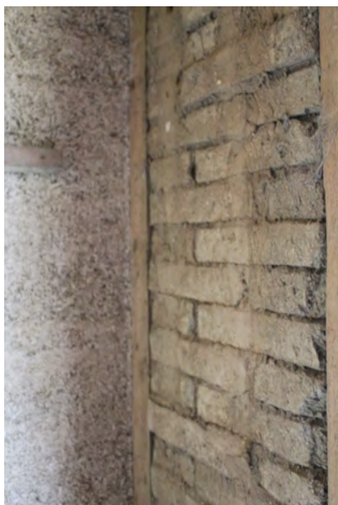
Dettaglio mattoni crudi e calcecanapa
