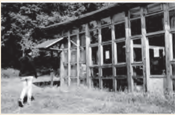
Impianto stand-alone biblioteca
