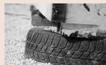
Particolare del riempimento dei copertoni
