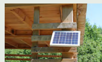
Particolare pannello solare
