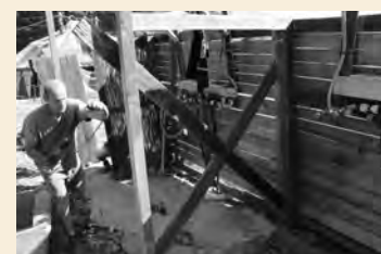
Docce solari in costruzione
