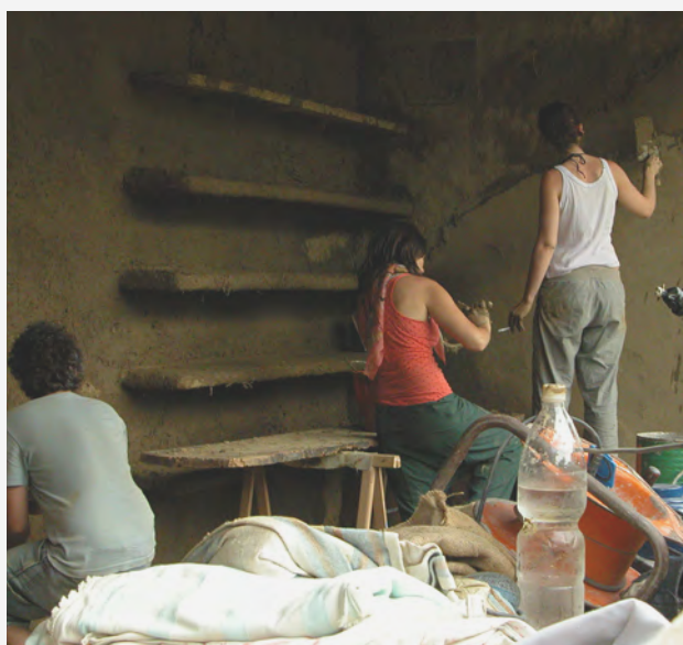
34/ Autocostruzione all'ecovillaggio di Granara
