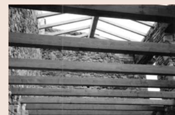
Tetto Granaio in costruzione
