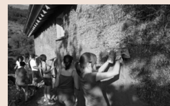
Stesura del rinzafo sull'esterno
