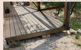
Particolare basamento ligneo della loggia
