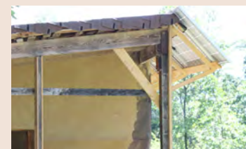
Particolare fronte nord
