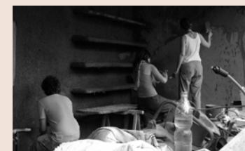
Biblioteca: fase posa intonaco
