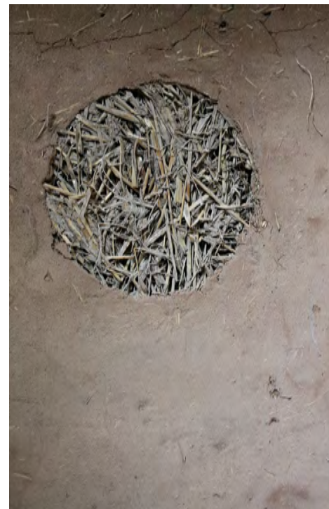
Intonaco in terra e terrapaglia visibile
