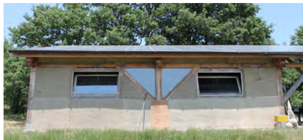
Vista da sud della tettoia-officina
