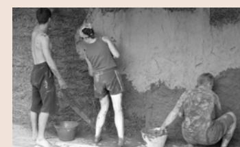
Posa intonaco di corpo
