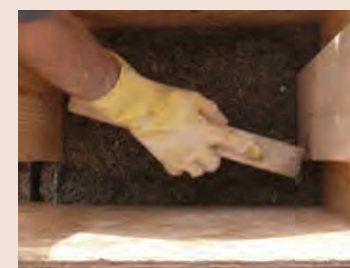
Fase di riempimento manuale nel cassero
