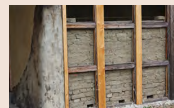
Nuova costruzione muro solare
