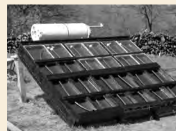
Pannelli solari in costruzione
