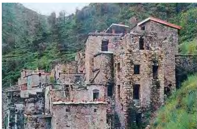
44/Torri Superiore prima del recupero
