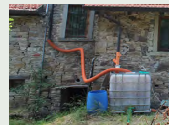
Cisterna Granara di Sotto
