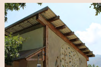
Copertura della tettoia officina
