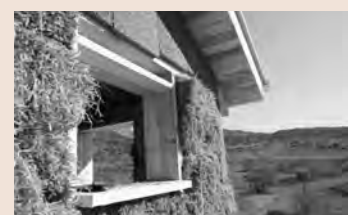
Apertura in fase di costruzione
