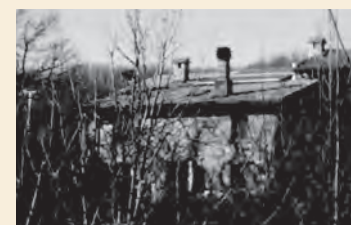
Casa Javier con pannelli
