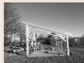
Tettoia officina in costruzione
