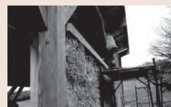
Riempimento in corso
