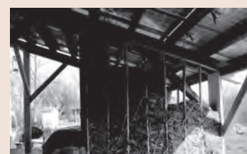
Riempimento in corso
