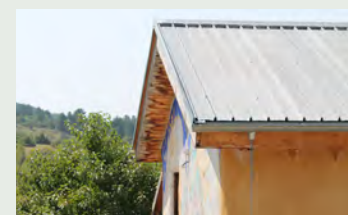
Attacco della cisterna alla gronda
