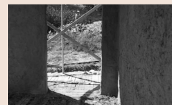
Casotto in fase di costruzione
