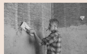
Stesura del primo strato all'interno
