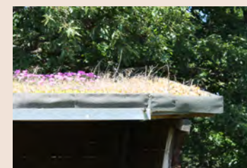
Dettaglio della copertura
