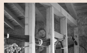
Struttura portante in fase di costruzione
