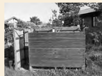
Docce solari incomplete
