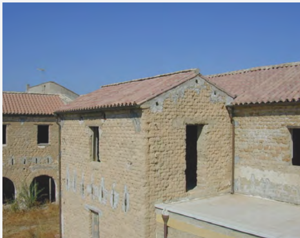
41/ Abitazione storica sarda in mattoni in terracuda
